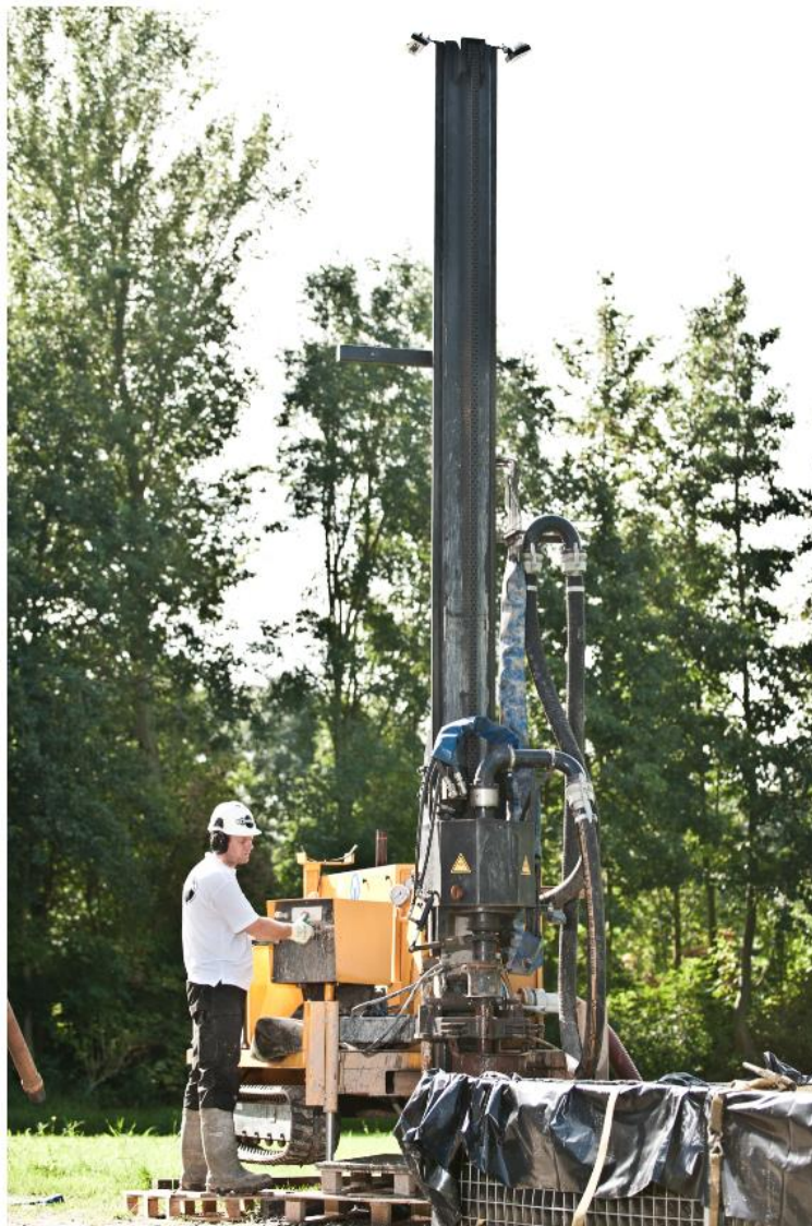
Figuur 1 Het boren van een gesloten bodemsysteem door BOMAR; bron Caleffi
